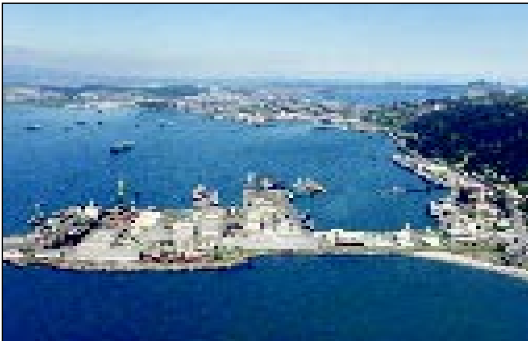
Vista aérea de la Planta Industrial de Asmar, Talcahuano.
