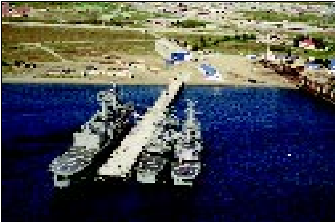
Muelle de reparaciones de ASMAR, Magallanes, en Bahía Catalina en Punta Arenas, puesto en servicio recientemente.
